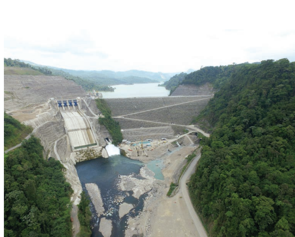
Presas hidroeléctricas (Foto. Archivo Grupo ICE)
